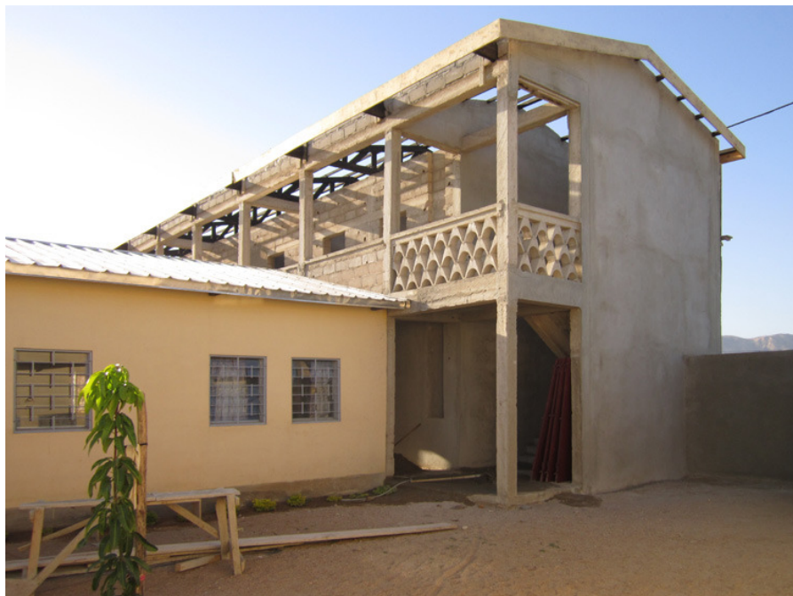
Am Hauptgebäude wird weiter gebaut. Die Dachkonstruktion ist fertig. Die Wände werden gerade verputzt. Auch der Mangobaum im Hof entwickelt sich prächtig.
