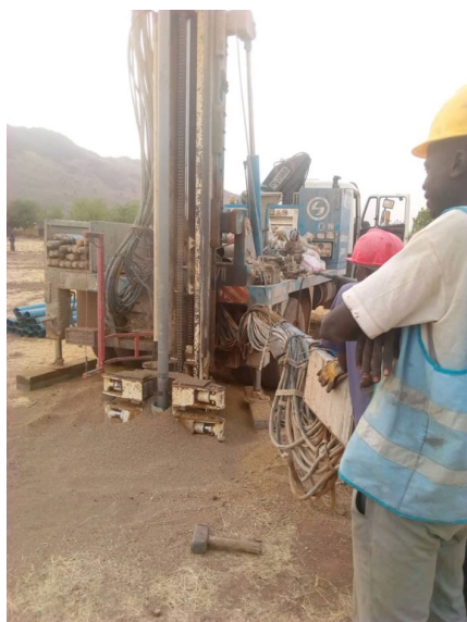
Beginn der Arbeiten in Adija
