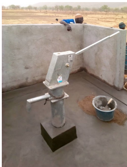
Das „Brunnenzimmer“ kurz vor der Fertigstellung
