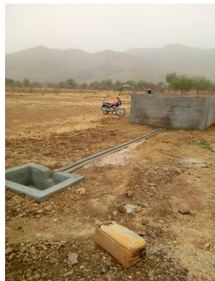
Der fertige Brunnen mit dem Ablauf in die Viehtränke
